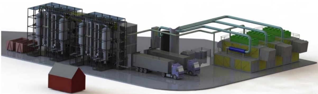
1. Attēls. NAIK gazifikācijas iekārta ar izejmateriāla iekraušanu tieši no autotransporta
